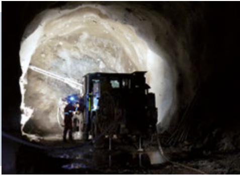
Construcción Túnel Barrio Satelital, Proyecto Nuevo Nivel Mina (El Teniente).
