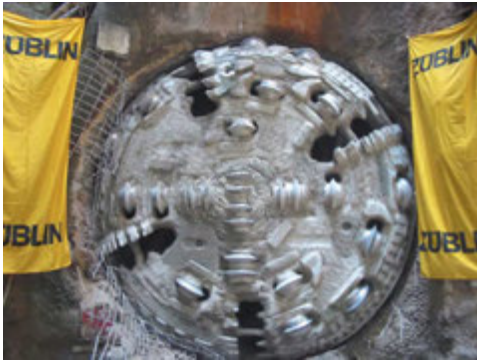
Rompimiento con TBM Proyecto Singapur.
